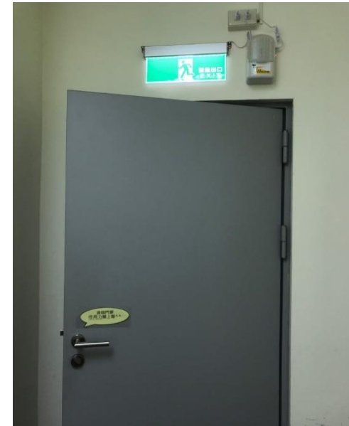
H101(A)個諮室設置緊急出口標示及照明設備，供避難逃生時使用。
