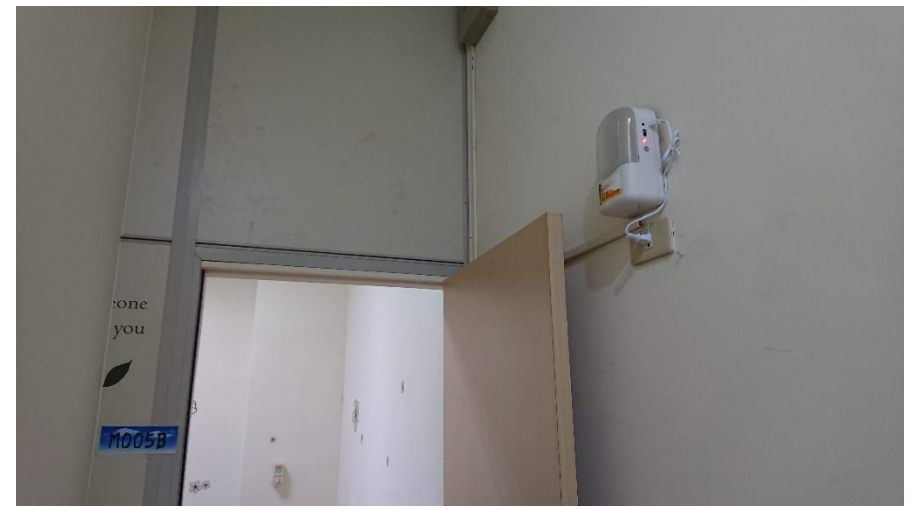
M005(B)個諮室設置緊急出口標示及照明設備，供避難逃生時使用。
