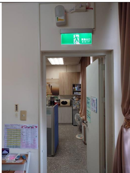
照片內容說明 L101 諮商室設置緊急出口及照明設備，供避難逃生時使用。
