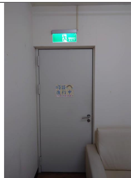
L101 諮商室設置緊急出口及照明設備，供避難逃生時使用。
