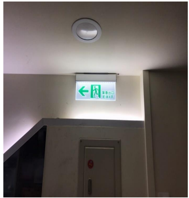
設置多處緊急照明逃生設備
